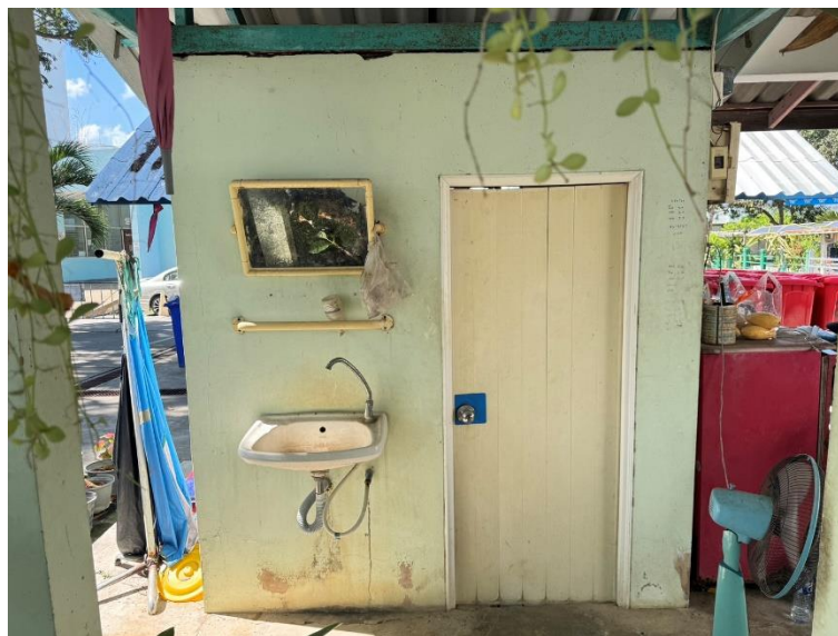
ห้องอาบน้ำ/สุขา
