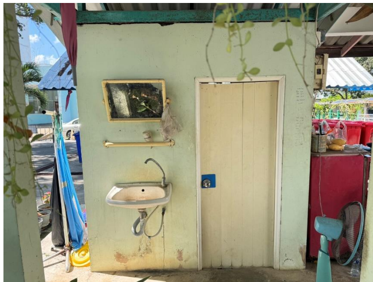
ห้องอาบน้ำ/สุขา
